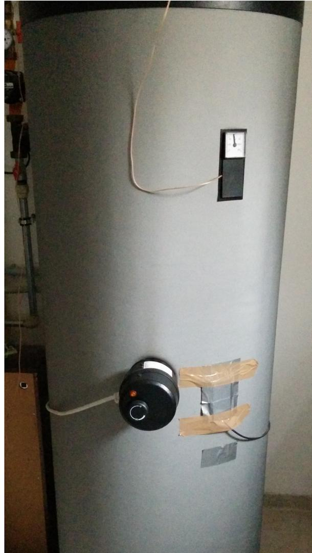
Abb. 10) Warmwasserspeicher mit Heizstab
