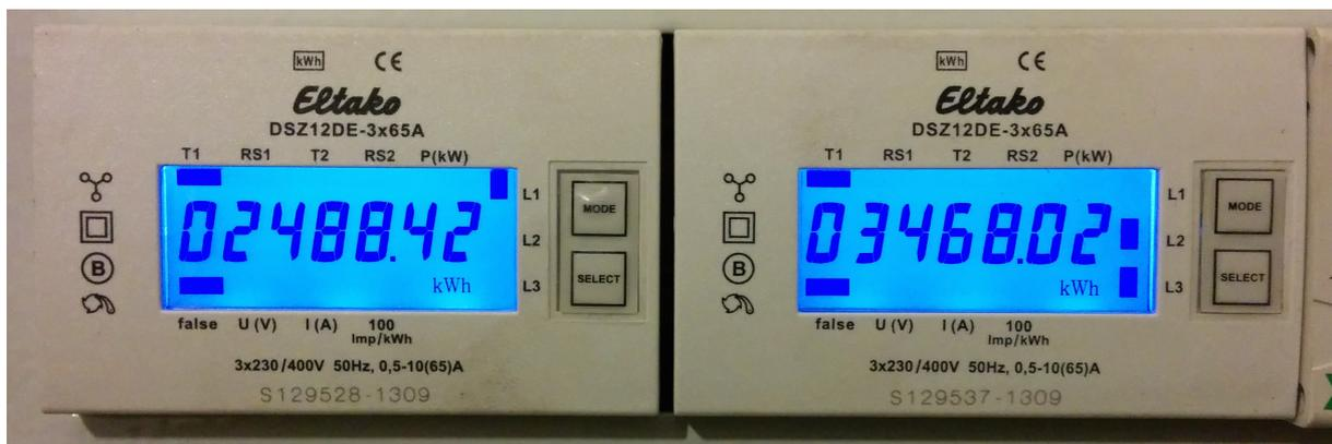
Abb. 8) Eltako DSZ12DE Drehstromzähler zum Erfassen von Strombezug und Stromlieferung
